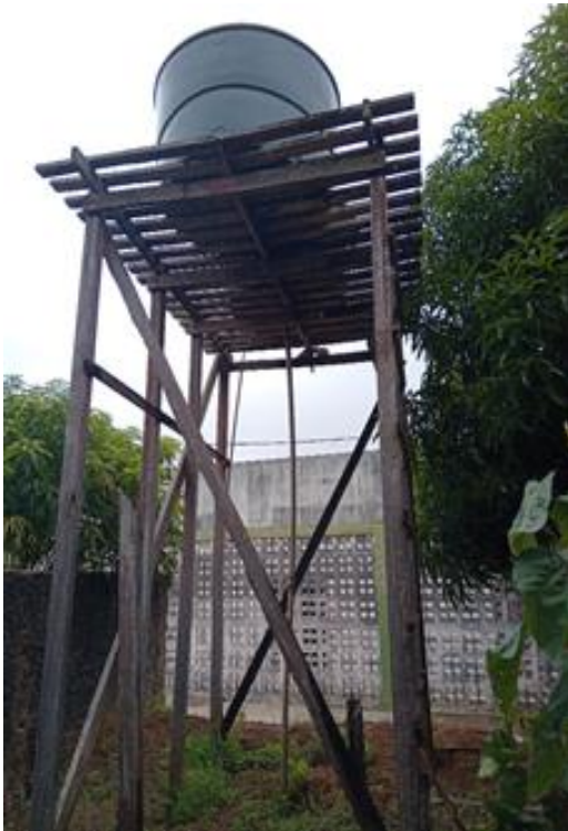
1-CASTELO DE CAIXA DE ÁGUA
